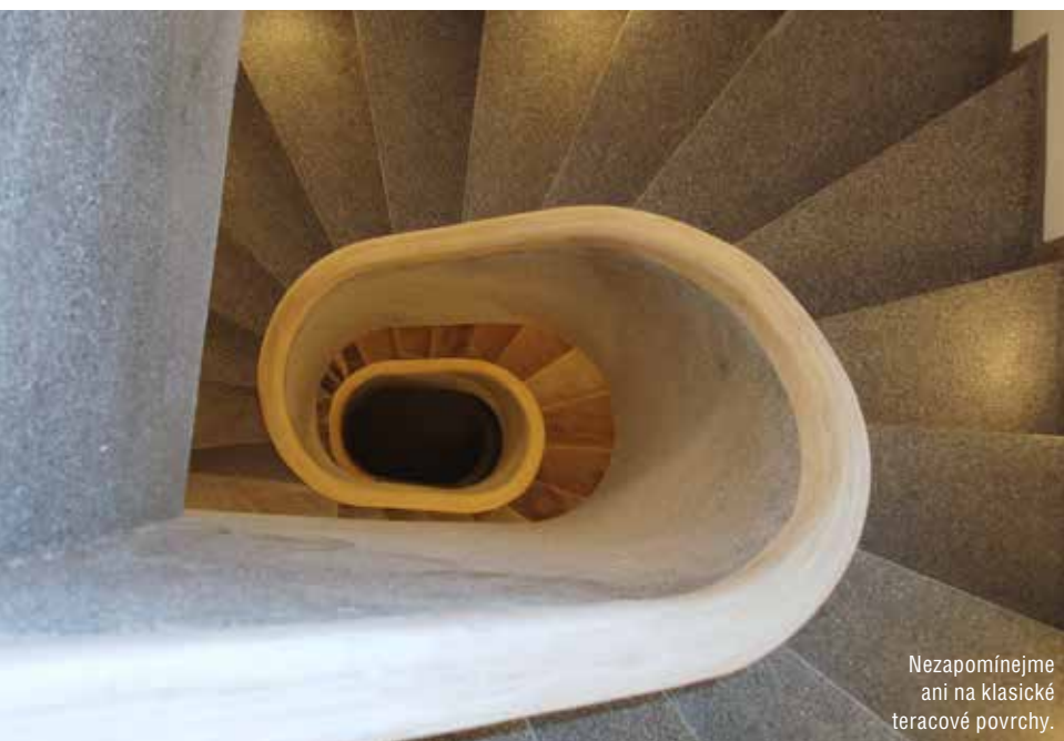
Také dlažba se dá kombinovat se stěrkami na podstupnicích. Kovová lišta na hrabě přesně oba materiály ohraničí.
