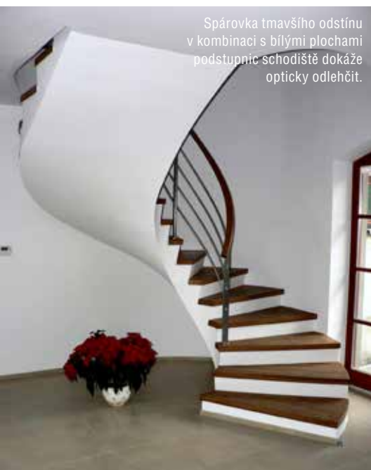
Pátevní betonový nosník můžete obložit přiměřeně tlustou spárovkou pomocí přechodové zapuštěné nerezové plotny.
