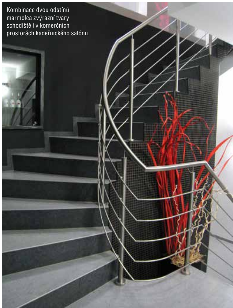
Také dlažba se dá kombinovat se stěrkami na podstupnicích. Kovová lišta na hrabě přesně oba materiály ohraničí.
